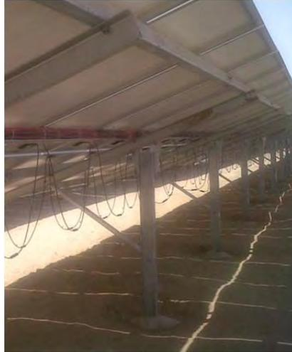
*Cimentación con micro pilote. Detalle de cimentación y acabado.*
