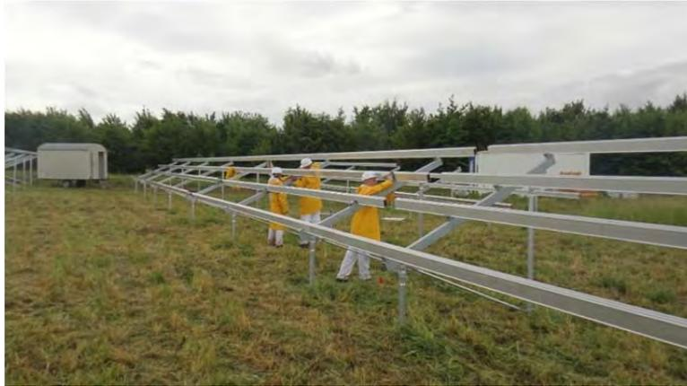
*Montaje de estructura fija con perfiles hincados directamente en el terreno.*
