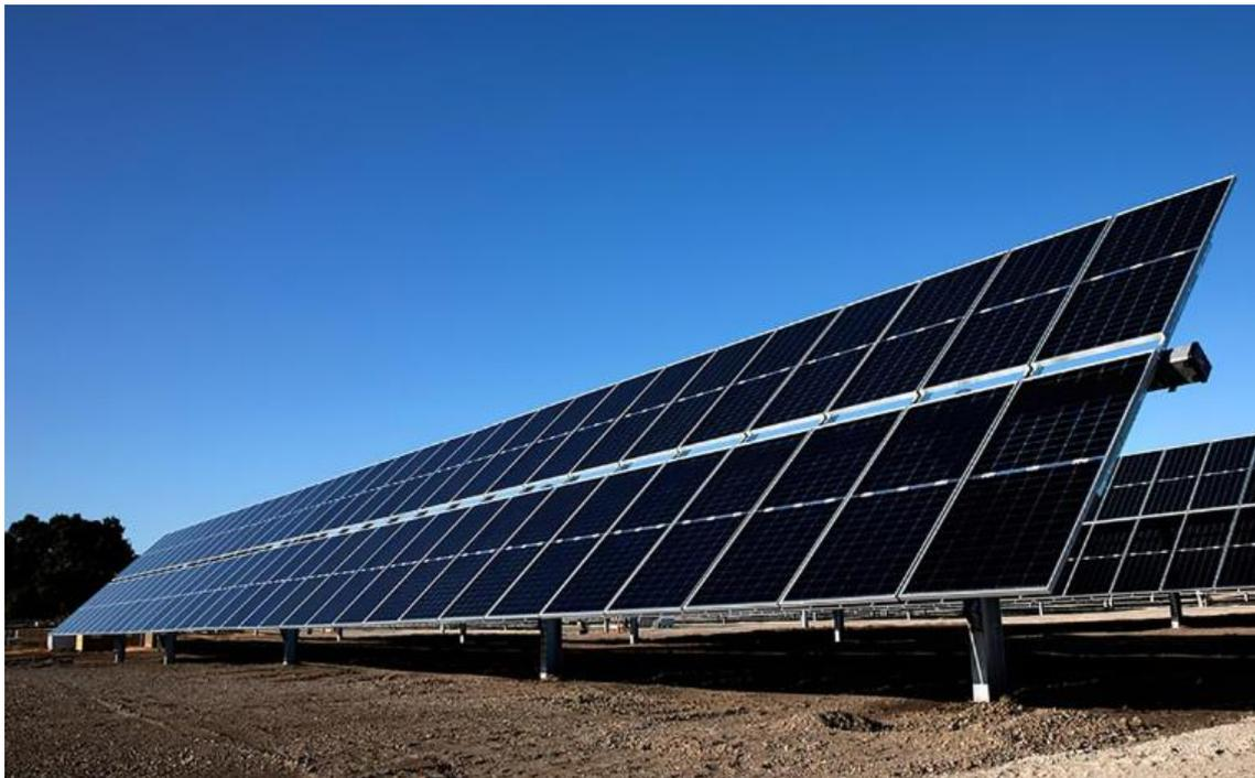
ILUSTRACIÓN 7: SEGUIDORES DE UN SOLO EJE
