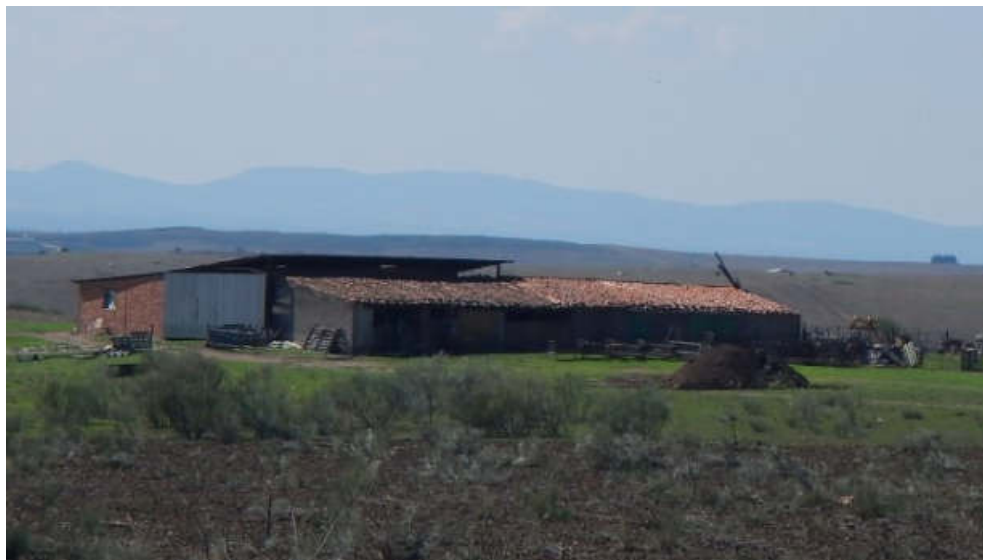
Figura 8. Conjunto edificatorio 4 – Edificaciones excluidas de la calificación Fuente: https://www1.sedecatastro.gob.es
