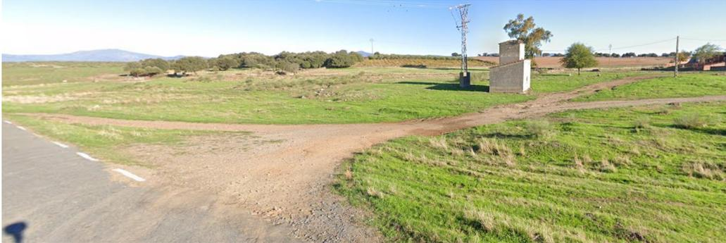
Al ser una carretera no catalogada y secundaria, no cuenta con suficiente señalización vertical y tampoco de líneas de separación de carriles, así como plataformas de acceso pavimentadas convenientemente. Por todo ello, será necesario solicitar el permiso para adecuar los accesos según el tipo de vehículos a utilizar durante las tareas de construcción y funcionamiento de la planta solar fotovoltaica. Contando eso sí este punto de acceso con buena visibilidad en ambos sentidos de la circulación.
