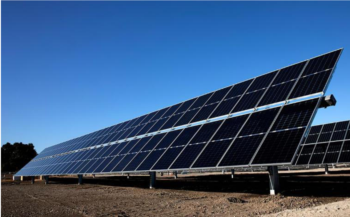
ILUSTRACIÓN 6: SEGUIDORES DE UN SOLO EJE
