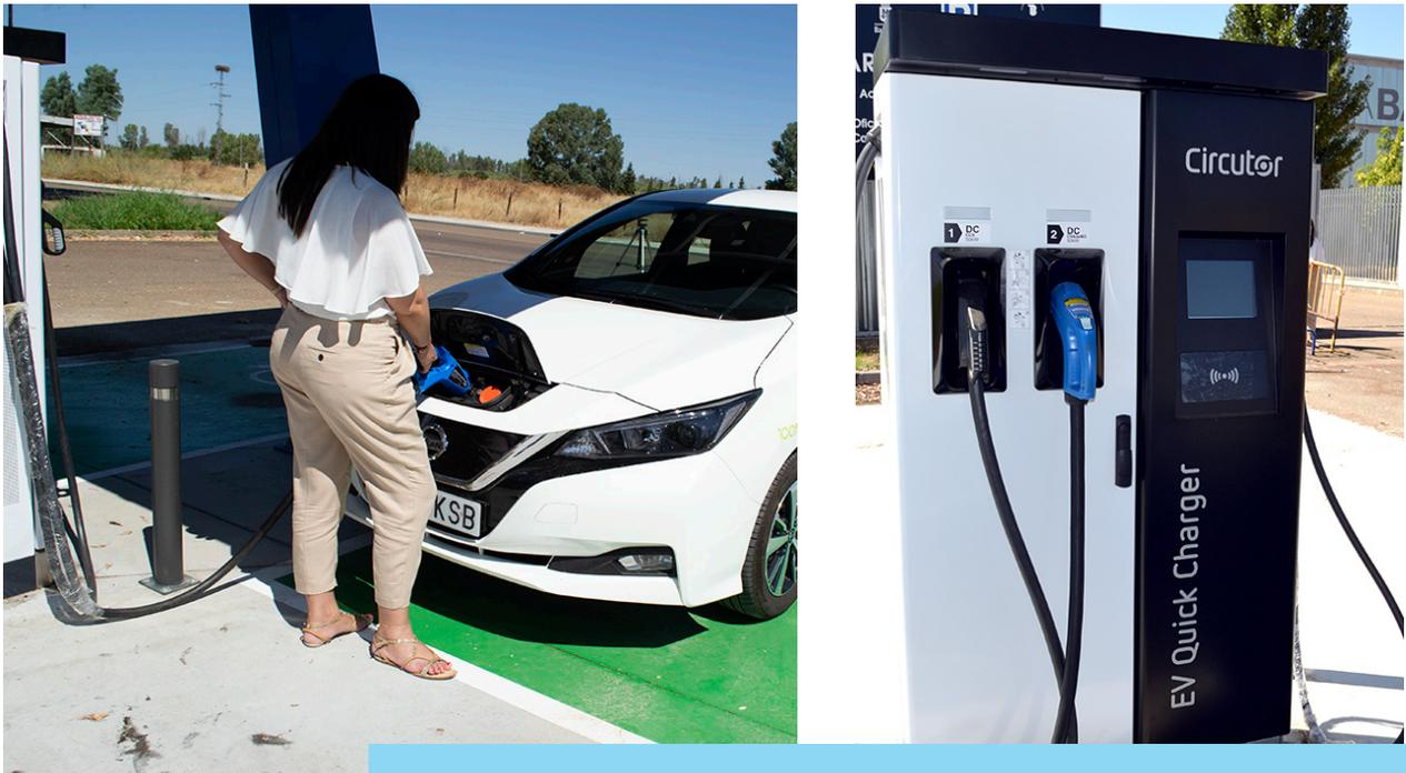
*Imagen 22. Estación de recarga en tránsito de 50 kW del Excmo. Ayto. de Badajoz en la Avda. de Elvas de Badajoz. Vehículo eléctrico perteneciente a la Excma. Diputación Provincial de Badajoz.*
