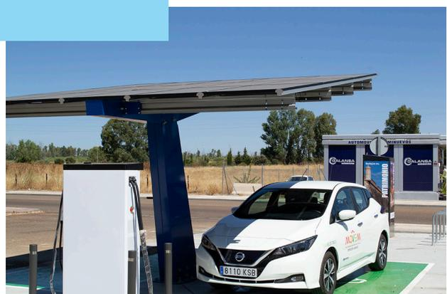
Imagen 30. Punto de recarga alimentado con instalación F.V. sobre marquesina. IFEBA. Ayuntamiento de Badajoz.
