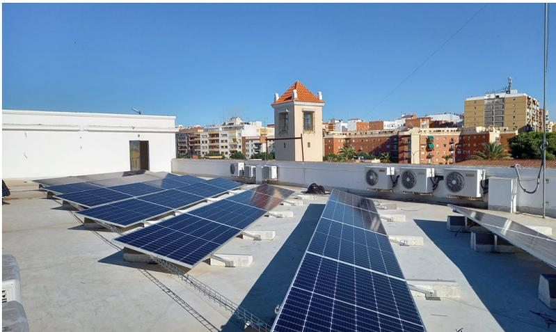
Imagen 29. Instalación F.V. sobre cubierta de las oficinas de la Agencia Extremeña de la Energía.
