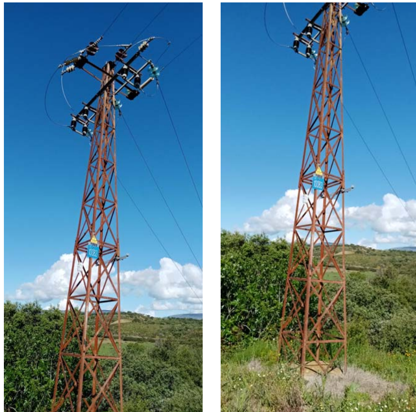
Apoyo 9000 de la L-"Perales" a desmontar
