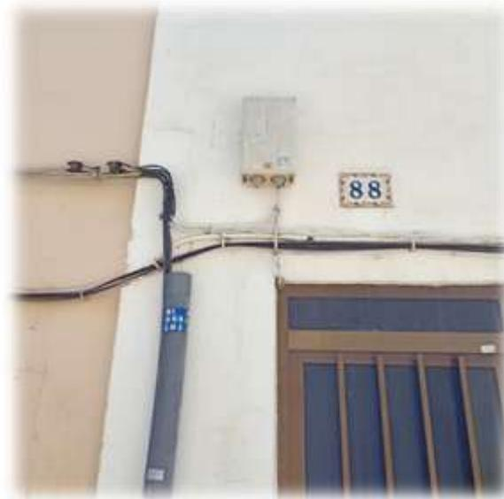
**Observaciones:** Acometida bifásica RZ 0,6/1 KV 2X16 AL conectada directamente en la transición existente en la propia fachada de la vivienda, que no cuenta con instalación interior según sistemas.
