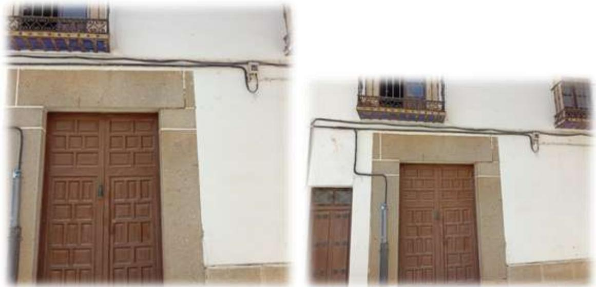
**Observaciones:** Acometida bifásica de cobre conectada a la caja existente en la propia fachada de la vivienda, que no cuenta con instalación interior según sistemas.
