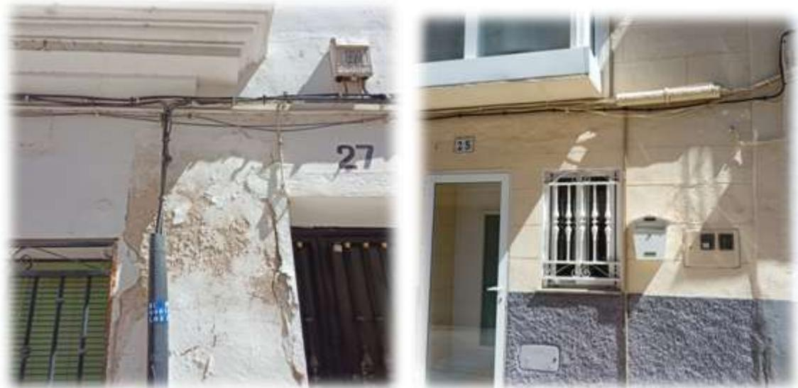
**Observaciones:** Acometida bifásica RZ 0,6/1 KV 2X25 AL, conectada en la transición existente en la fachada de la vivienda N°27, por lo que la instalación interior se encuentra en la actualidad conectada entre dos fases. Una vez realizado el paso a B2 será necesario conectar dicha acometida entre fase y neutro.
