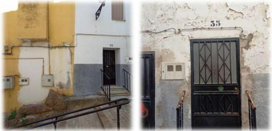
**Observaciones:** Acometida bifásica de cobre conectada a la caja existente en la vivienda N°31 de la misma calle, que no cuenta con instalación interior según sistemas.
