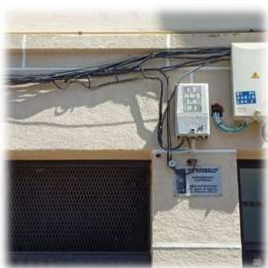
**Observaciones:** Acometida trifásica de cobre, destinada a la alimentación del ascensor del edificio ubicado en el N°3.
