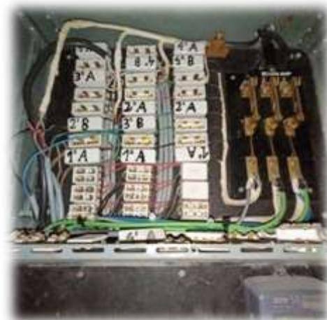
**Observaciones:** Acometida trifásica de cobre. Las instalaciones interiores se encuentran conectadas en la actualidad entre dos fases, no presentado el embarrado de la centralización de contadores pletina de neutro.
