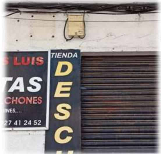
**Observaciones:** Acometida bifásica de cobre, por lo que la instalación interior se encuentra en la actualidad conectada entre dos fases. Una vez realizado el paso a B2 será necesario conectar dicha acometida entre fase y neutro.
