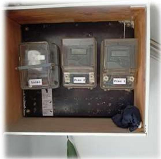
**Observaciones:** Acometida trifásica RZ 0,6/1 KV 4X16 AL. Las instalaciones interiores se encuentran conectadas en la actualidad entre dos fases, existiendo contadores con fusibles acoplados por cada uno de los suministros existentes en el edificio. Es por ellos que deberá eliminarse el fusible de la fase que pasa a neutro, de forma que se asegure la no interrupción del neutro. Una vez realizado el cambio a B2 de la red, será necesario conectar la instalación interior entre fase y neutro.
