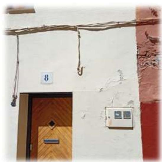
**Observaciones:** Acometida bifásica RZ 0,6/1 KV 2X16 AL conectada en la esquina de la calle Peligros con la calle Ancha, por lo que la instalación interior se encuentra en la actualidad conectada entre dos fases. Una vez realizado el paso a B2 será necesario conectar dicha acometida entre fase y neutro.
