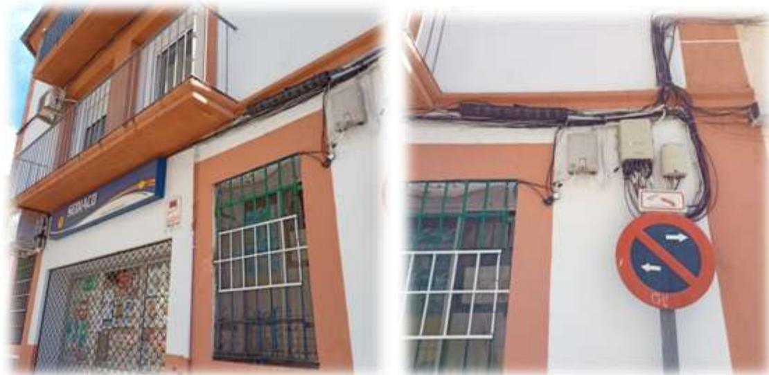
**Observaciones:** Acometida bifásica RZ 0,6/1 KV 2X25 AL, por lo que la instalación interior se encuentra en la actualidad conectada entre dos fases. Una vez realizado el paso a B2 será necesario conectar dicha acometida entre fase y neutro.
