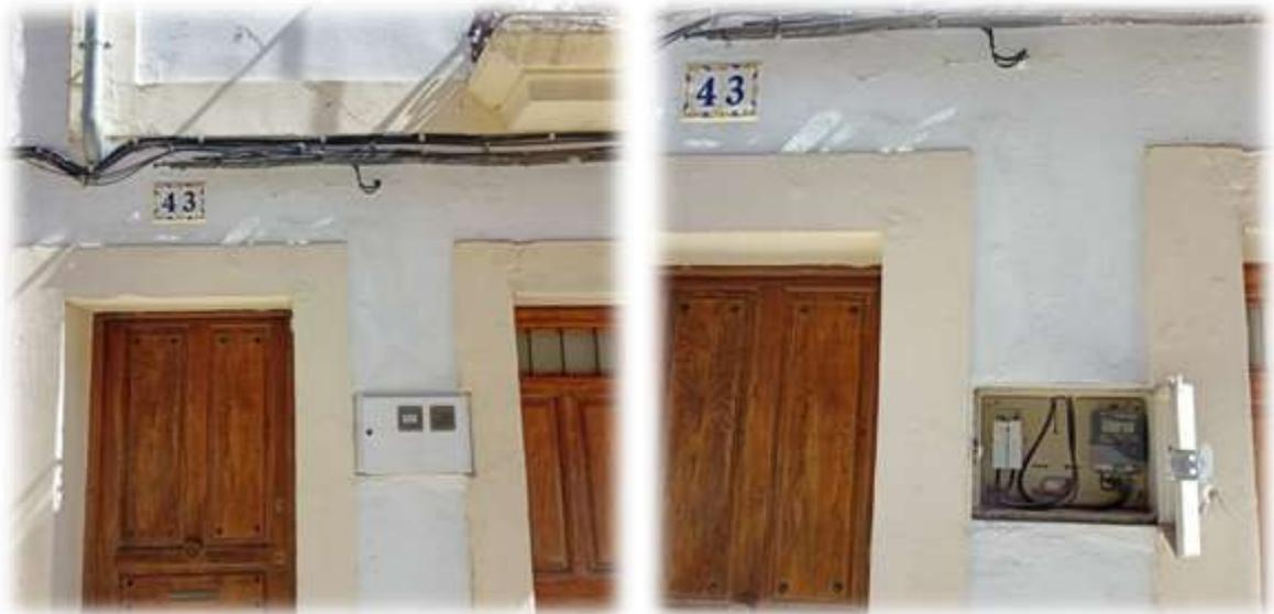
**Observaciones:** Acometida bifásica RZ 0,6/1 KV 2X25 AL. por lo que la instalación interior se encuentra en la actualidad conectada entre dos fases. Una vez realizado el paso a B2 será necesario conectar dicha acometida entre fase y neutro.
