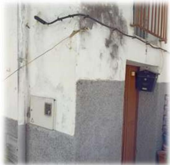
**Observaciones:** Acometida bifásica de cobre conectada a la caja de reparto existente en la vivienda N°2 de la misma calle, por lo que la instalación interior se encuentra en la actualidad conectada entre dos fases. Una vez realizado el paso a B2 será necesario conectar dicha acometida entre fase y neutro.
