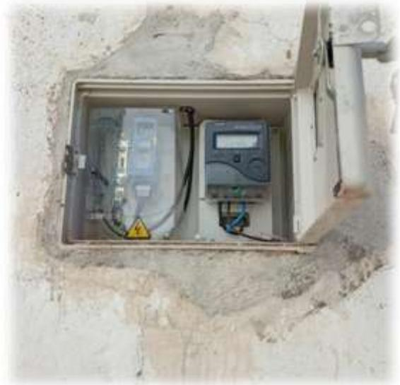
**Observaciones:** Acometida bifásica RZ 0,6/1 KV 2X16 AL, por lo que la instalación interior se encuentra en la actualidad conectada entre dos fases. Una vez realizado el paso a B2 será necesario conectar dicha acometida entre fase y neutro.
