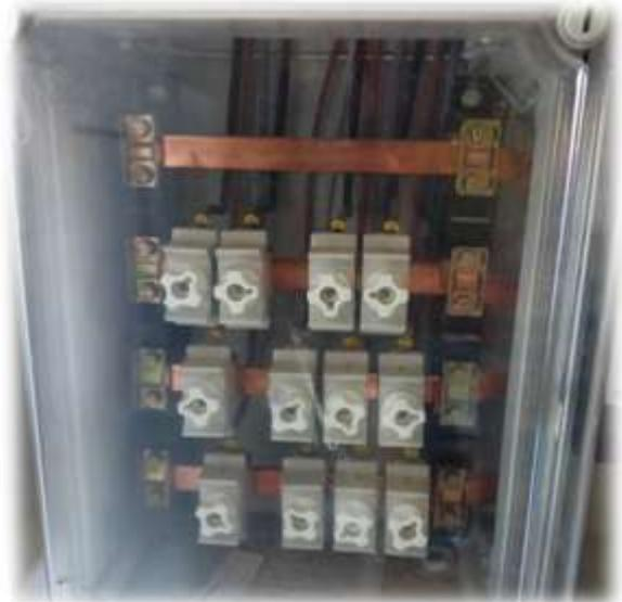
**Observaciones:** Acometida trifásica RZ 0,6/1 KV 4X16 AL. Las instalaciones interiores se encuentran conectadas en la actualidad entre dos fases, presentado el embarrado de la centralización de contadores pletina de neutro. Es por ello que una vez realizado el paso a B2 será necesario conectar estas instalaciones interiores entre fase y neutro.
