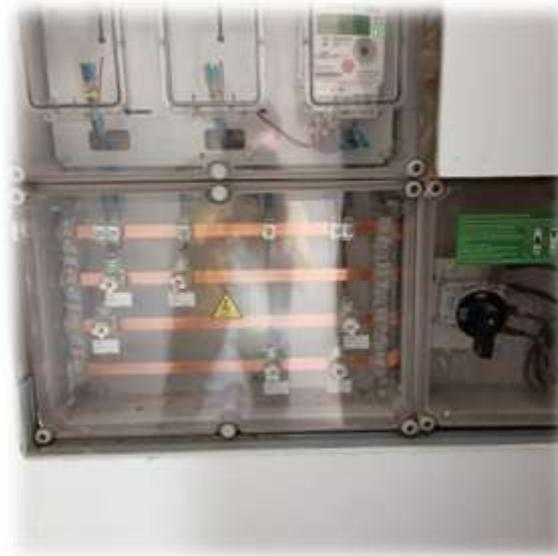
**Observaciones:** Acometida bifásica RZ 0,6/1 KV 2X25 AL. por lo que la instalación interior se encuentra en la actualidad conectada entre dos fases. Una vez realizado el paso a B2 será necesario conectar dicha acometida entre fase y neutro.
