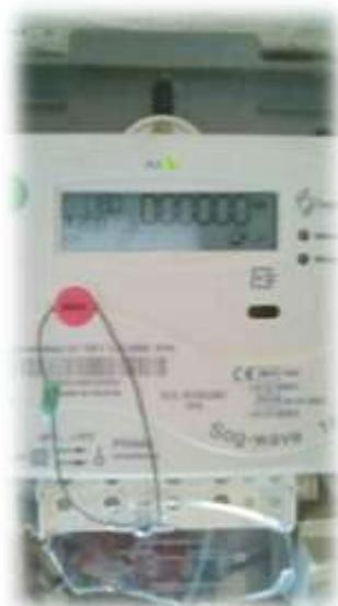
En este caso, como consecuencia del paso a B2, y debido a que la instalación interior cuenta con un contador con dos fusibles acoplados, deberá eliminarse el fusible de la fase que pasa a neutro, de forma que se asegure la no interrupción del neutro.
