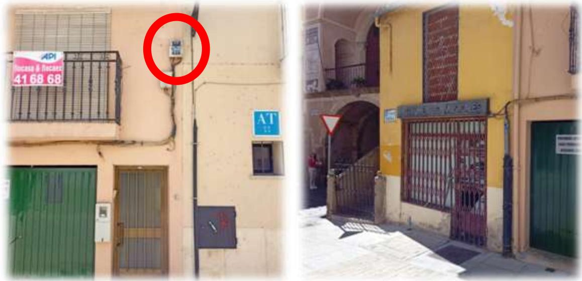
**Observaciones:** Acometida bifásica de cobre conectada a la caja de reparto existente en la vivienda N°100 de la misma calle, que no cuenta con instalación interior según sistemas.
