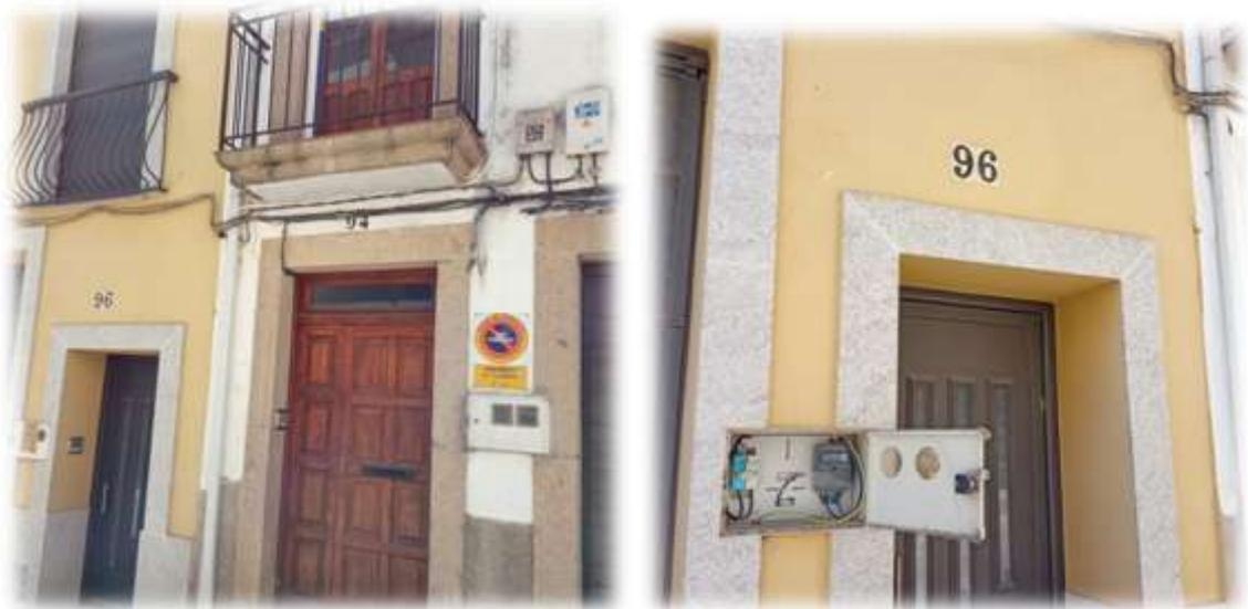
**Observaciones:** Acometida bifásica RZ 0,6/1 KV 2X16 AL conectada en el final de línea existente en la fachada de la vivienda N°94, por lo que la instalación interior se encuentra en la actualidad conectada entre dos fases. Una vez realizado el paso a B2 será necesario conectar dicha acometida entre fase y neutro.
