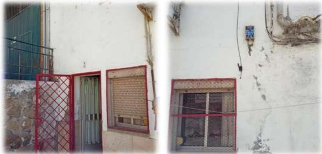
**Observaciones:** Acometida trifásica de cobre, que por tratarse de una instalación interior bifásica se encuentra en la actualidad conectada entre dos fases. Una vez realizado el paso a B2 será necesario conectar dicha instalación interior entre fase y neutro.
