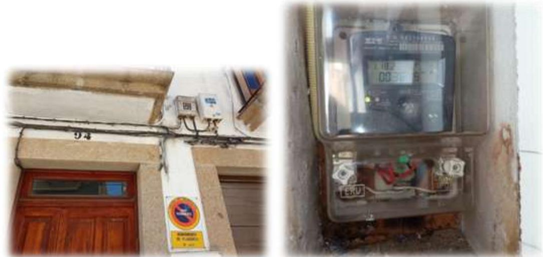
**Observaciones:** Acometida bifásica de cobre por lo que la instalación interior se encuentra en la actualidad conectada entre dos fases. Una vez realizado el paso a B2 será necesario conectar dicha acometida entre fase y neutro.
