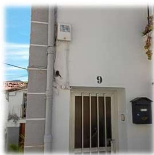
**Observaciones:** Acometida bifásica RZ 0,6/1 KV 2X16 AL, conectada a la caja de reparto existente en la vivienda N°2 de la misma calle, por lo que la instalación interior se encuentra en la actualidad conectada entre dos fases. Una vez realizado el paso a B2 será necesario conectar dicha acometida entre fase y neutro.
