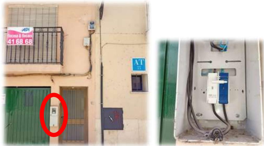
**Observaciones:** Acometida bifásica RZ 0,6/1 KV 2X16 AL, por lo que la instalación interior se encuentra en la actualidad conectada entre dos fases. Una vez realizado el paso a B2 será necesario conectar dicha acometida entre fase y neutro.
