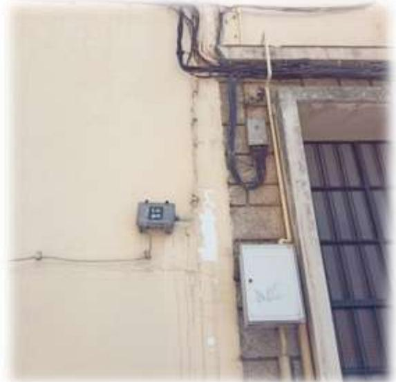
**Observaciones:** Acometida trifásica de cobre que no cuenta con instalación interior según sistemas.
