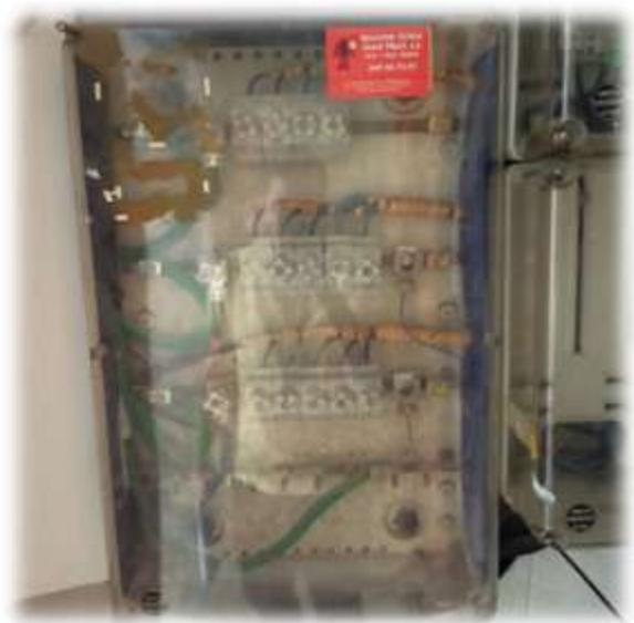
**Observaciones:** Acometida trifásica RZ 0,6/1 KV 3X50/54,6 ALM. Las instalaciones interiores se encuentran conectadas en la actualidad entre dos fases, presentado el embarrado de la centralización de contadores pletina de neutro. Es por ello que una vez realizado el paso a B2 será necesario conectar estas instalaciones interiores entre fase y neutro.
