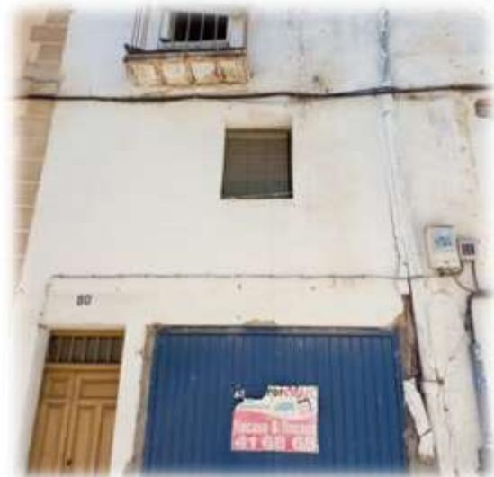
**Observaciones:** Acometida bifásica de cobre conectada a la caja existente en la vivienda N°78 de la misma calle, por lo que la instalación interior se encuentra en la actualidad conectada entre dos fases. Una vez realizado el paso a B2 será necesario conectar dicha acometida entre fase y neutro.
