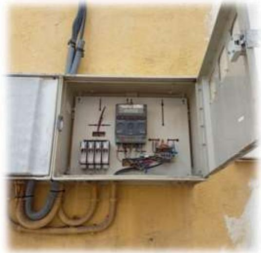
**Observaciones:** Acometida trifásica de cobre. El cuadro del alumbrado se encuentra conectado en la actualidad entre tres fases y neutro, por lo que se encuentra en adaptado al cambio de la tensión de suministro a B2.
