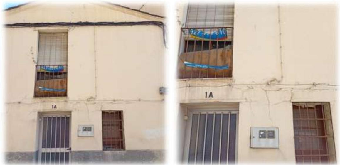
**Observaciones:** Acometida bifásica RZ 0,6/1 KV 2X16 AL, que no cuenta con instalación interior según sistemas.
