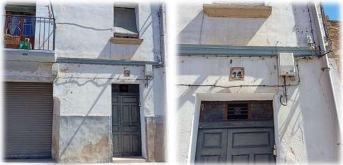
**Observaciones:** Acometida trifásica RZ 0,6/1 KV 4X16 AL. No se ha podido acceder al interior del edificio, por lo que se desconoce el tipo de conexión de las instalaciones interiores. No se ha podido comprobar por tanto si presenta centralización de contadores y si esta cuenta con pletina de neutro o si por el contrario simplemente existe un contador con dos fusibles acoplados al mismo.
