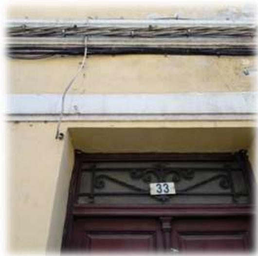
**Observaciones:** Acometida trifásica RZ 0,6/1 KV 4X16 AL. No se ha podido acceder al interior del edificio, por lo que se desconoce el tipo de conexión de las instalaciones interiores. No se ha podido comprobar por tanto si presenta centralización de contadores y si esta cuenta con pletina de neutro o si por el contrario simplemente existe un contador con dos fusibles acoplados al mismo.
