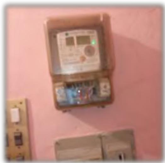
**Observaciones:** Acometida bifásica de cobre por lo que la instalación interior se encuentra en la actualidad conectada entre dos fases. Una vez realizado el paso a B2 será necesario conectar dicha acometida entre fase y neutro.
