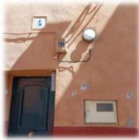
**Observaciones:** Acometida bifásica RZ 0,6/1 KV 2X16 AL, por lo que la instalación interior se encuentra en la actualidad conectada entre dos fases. Una vez realizado el paso a B2 será necesario conectar dicha acometida entre fase y neutro.
