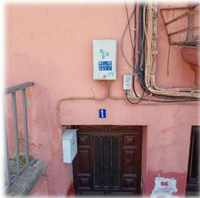
**Observaciones:** Acometida trifásica RZ 0,6/1 KV 4X16 AL, que por tratarse de una instalación interior bifásica se encuentra en la actualidad conectada entre dos fases. Una vez realizado el paso a B2 será necesario conectar dicha instalación interior entre fase y neutro.
