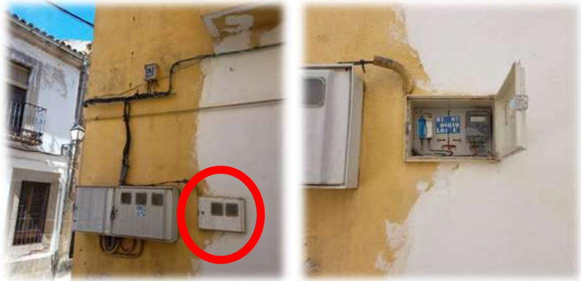
**Observaciones:** Acometida bifásica RZ 0,6/1 KV 2X16 AL. por lo que la instalación interior se encuentra en la actualidad conectada entre dos fases. Una vez realizado el paso a B2 será necesario conectar dicha acometida entre fase y neutro.
