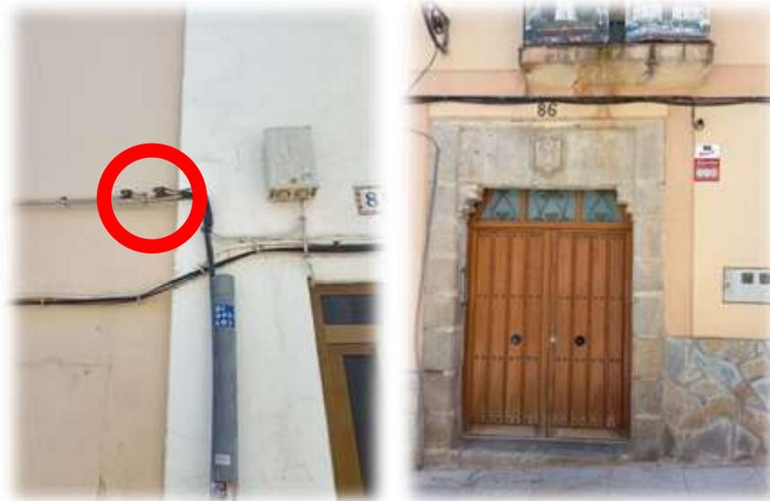
**Observaciones:** Acometida bifásica RZ 0,6/1 KV 2X16 AL. conectada a la transición existente en la vivienda N°88 de la misma calle, por lo que la instalación interior se encuentra en la actualidad conectada entre dos fases. Una vez realizado el paso a B2 será necesario conectar dicha acometida entre fase y neutro.
