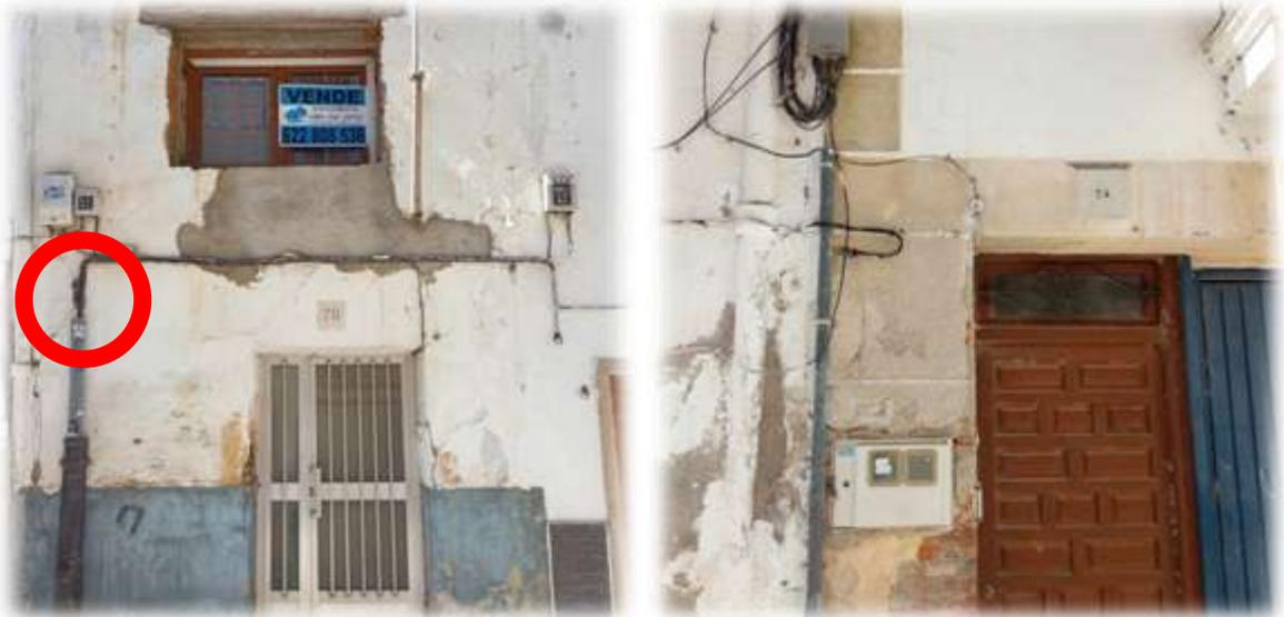
**Observaciones:** Acometida bifásica RZ 0,6/1 KV 2X16 AL conectada directamente en la transición existente en la vivienda N°78 de la misma calle, que no cuenta con instalación interior según sistemas.
