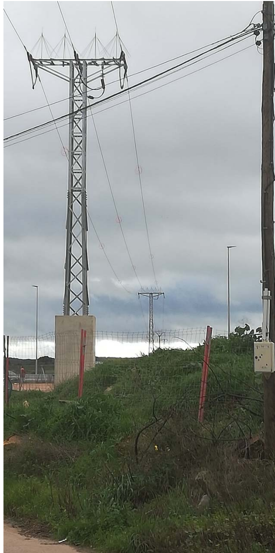
Apoyo 5021-1 a desmontar
