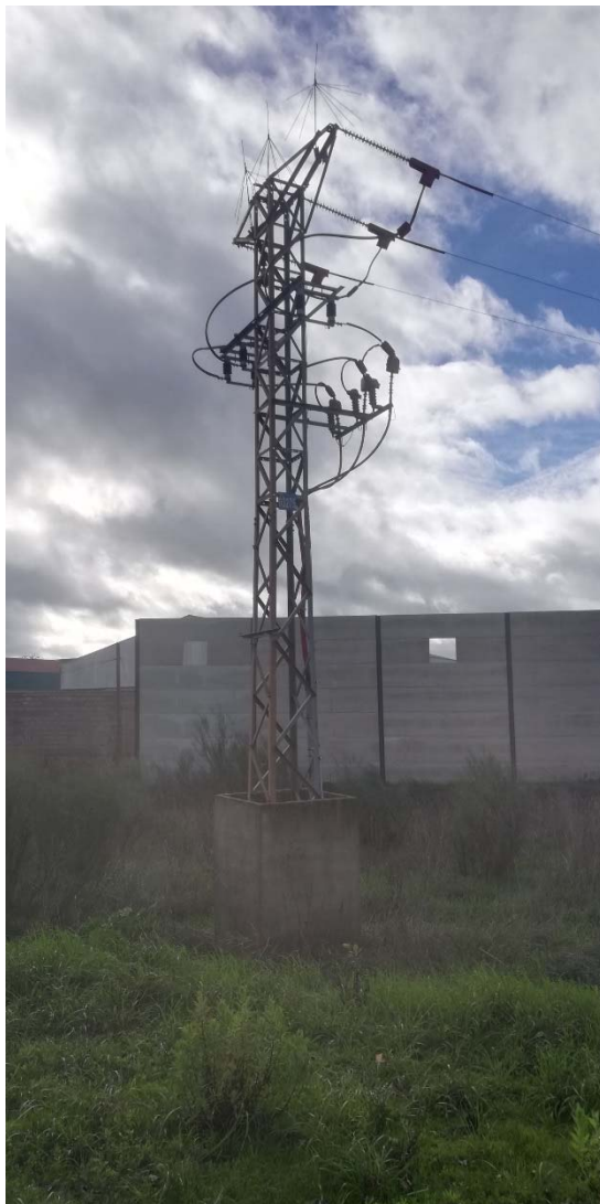
Apoyo 2068 a desmontar - empalmes con la LSMT existente que baja del mismo
