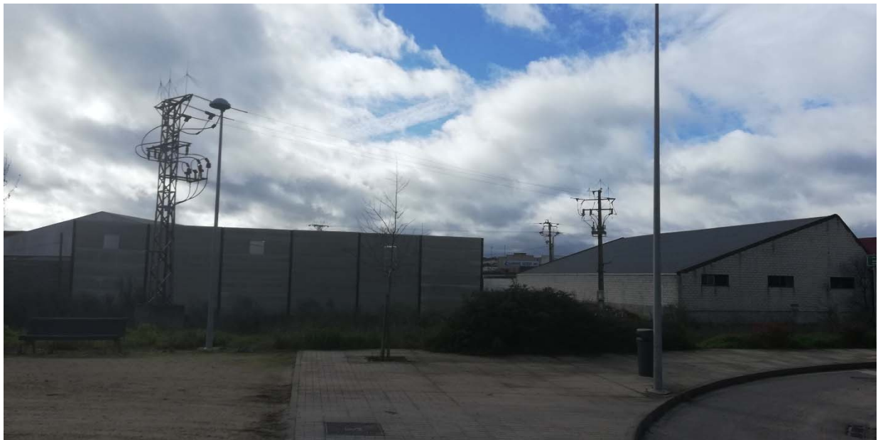
Apoyos 2067 y 2068 a desmontar
