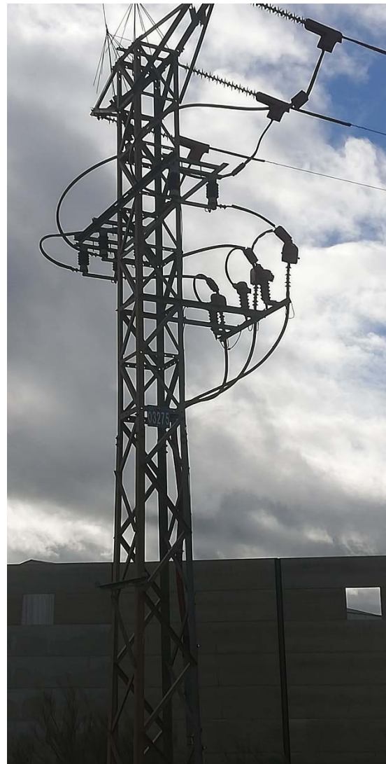
Apoyo 2068 a desmontar - empalmes con la LSMT existente que baja del mismo
