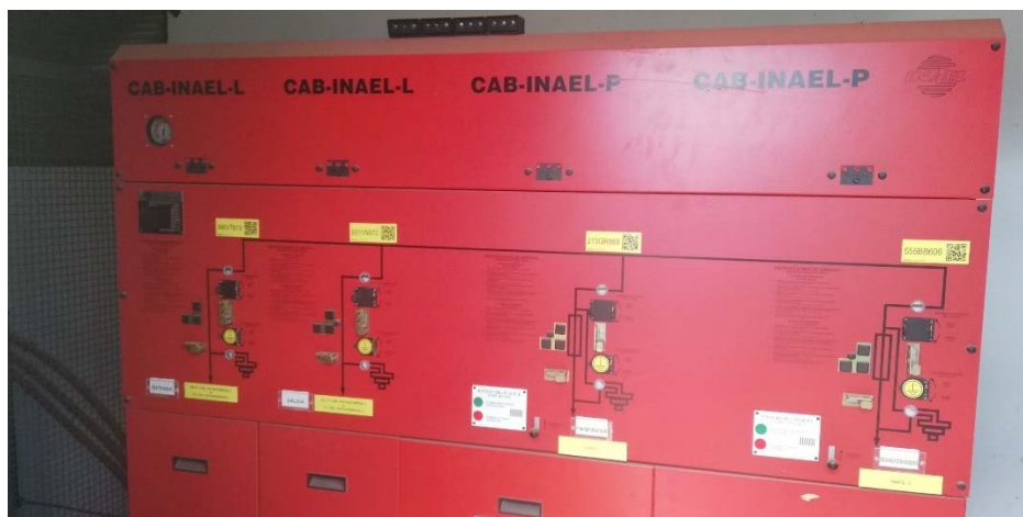
Celdas y aparamenta existente en el CT “Urb. Vistahermosa 3”
