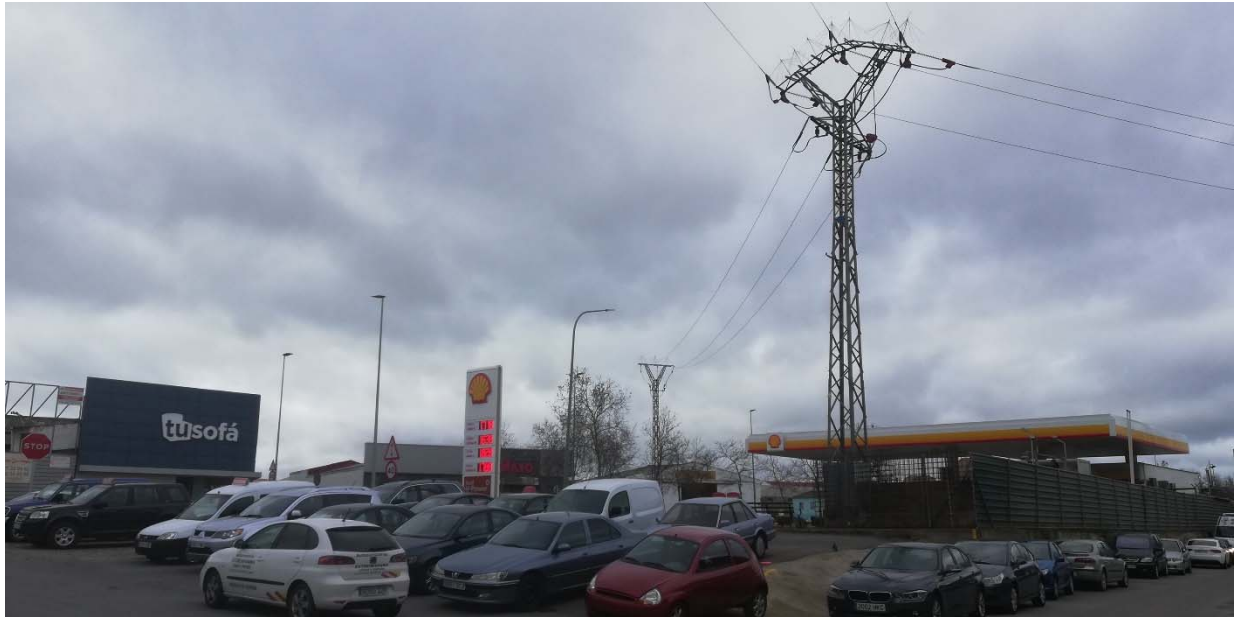
Apoyos 5020 y 2065 a desmontar
