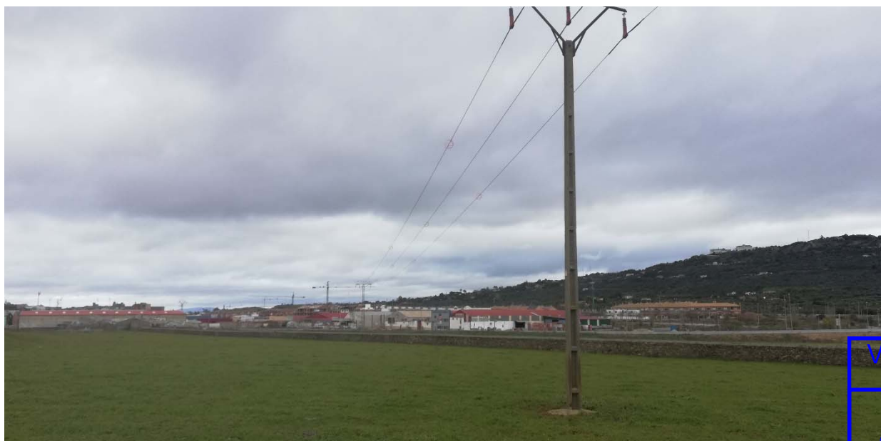
Apoyos 5022 y 5023 a desmontar
