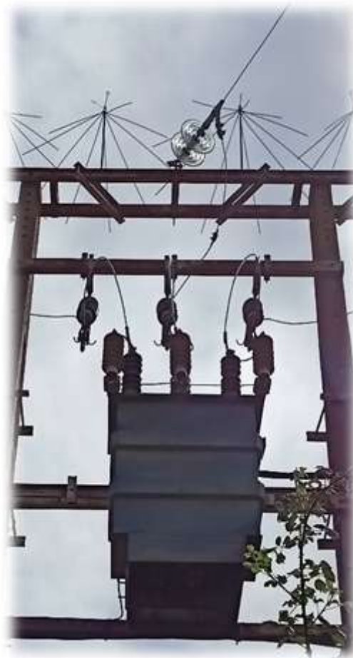
Trafo CTIA “Sauceda” a desmontar
