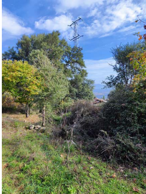
Apoyo 2011 a desmontar
