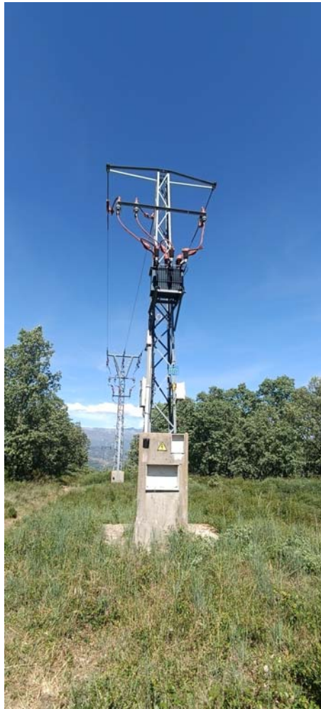
Apoyo 1021-1 de la L-“Circunvalación 2” a mantener y CTIA “Cerro Cabezas”
