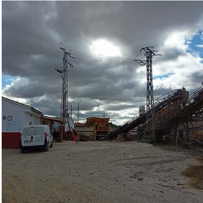
Apoyo 7201 de la L-“Riegos Alagón” (a desmontar) y apoyo particular a desmontar Alimentación a CT cliente “Gravera” N°140353920
