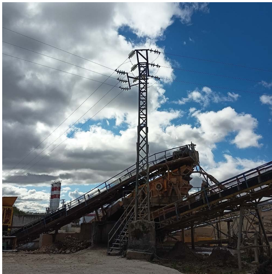
Apoyo 7201 de la L-“Riegos Alagón” (a desmontar)
