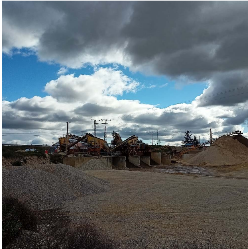
Apoyo 7201 de la L-“Riegos Alagón” (a desmontar) y apoyo particular a desmontar
