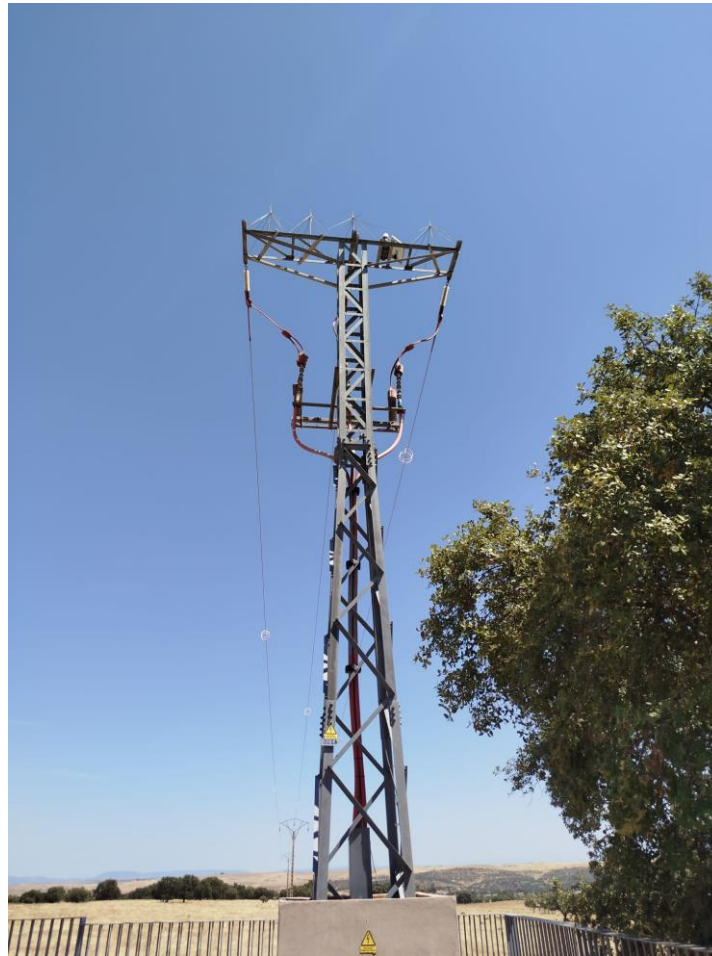
Apoyo 2016 a desmontar y LSAT que baja del mismo
