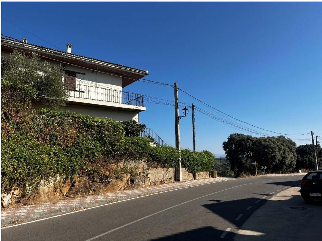
*Tramo de LABT y apoyo de hormigón a desmontar*
