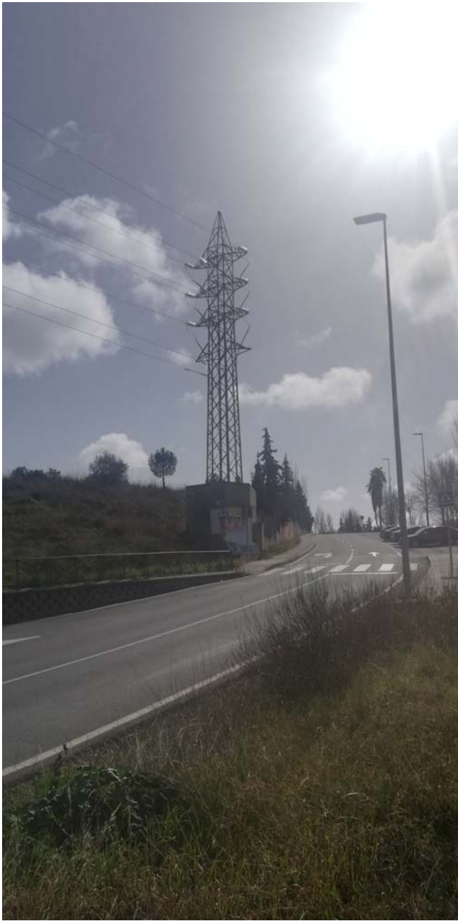
Apoyo 9005 a desmontar
