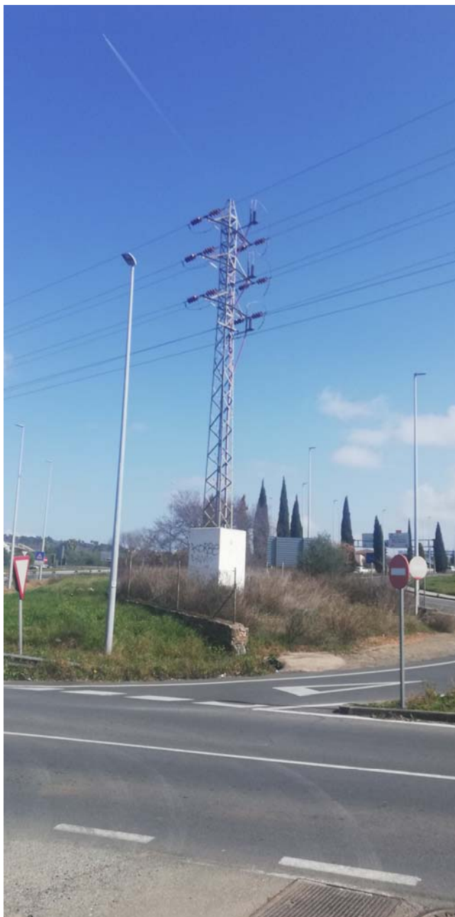
Apoyo 9004 a desmontar
