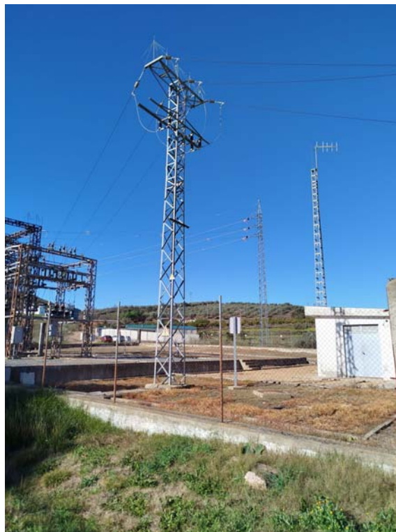
Apoyo 5000 existente a desmontar
