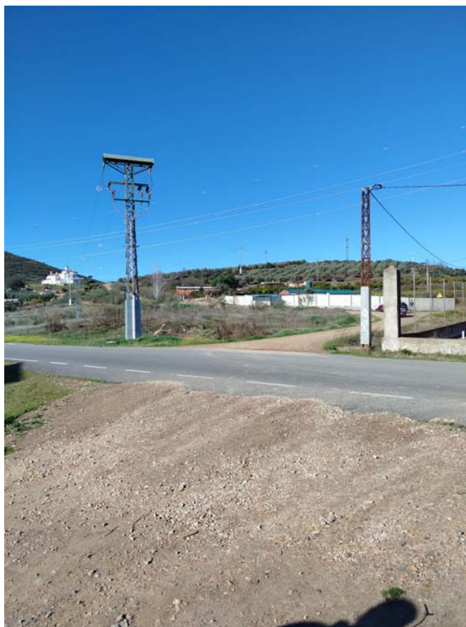
Apoyo 5143 a mantener en el que se sustituirá el entronque A/S existente
