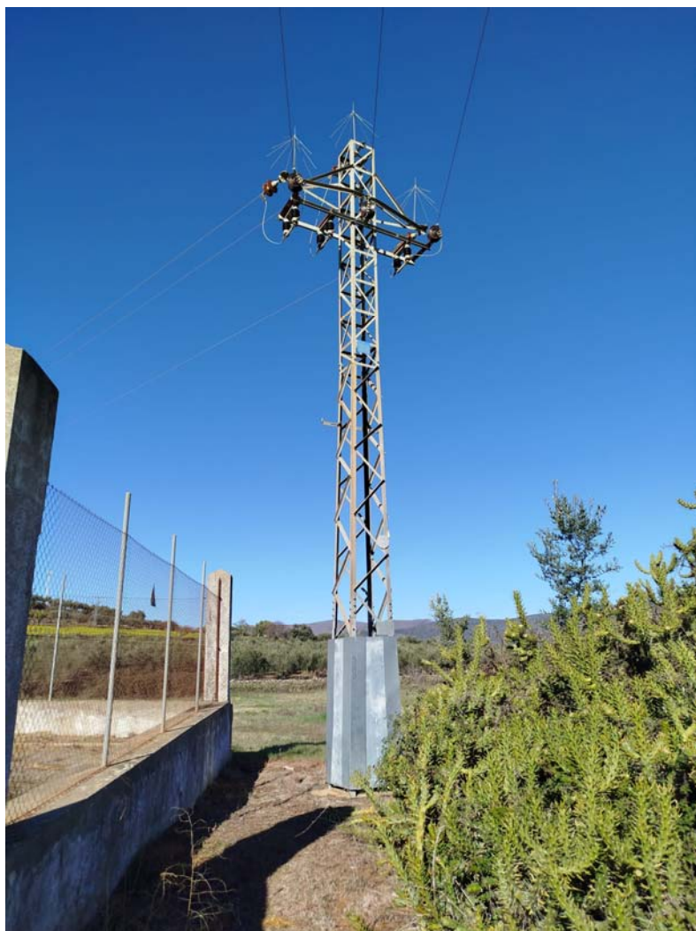
Apoyo 5002 existente a mantener, en el que se realizará un entronque aéreo-subterráneo
