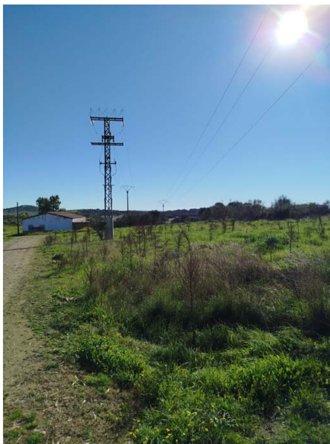
Apoyo 5001 de la L-“Río Ruelas” en el que se sustituirá el entronque A/S existente
