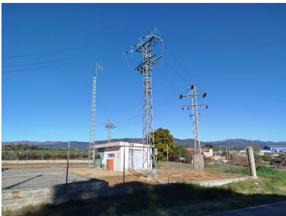
Apoyo 5002 existente a mantener, en el que se realizará un entronque aéreo-subterráneo
