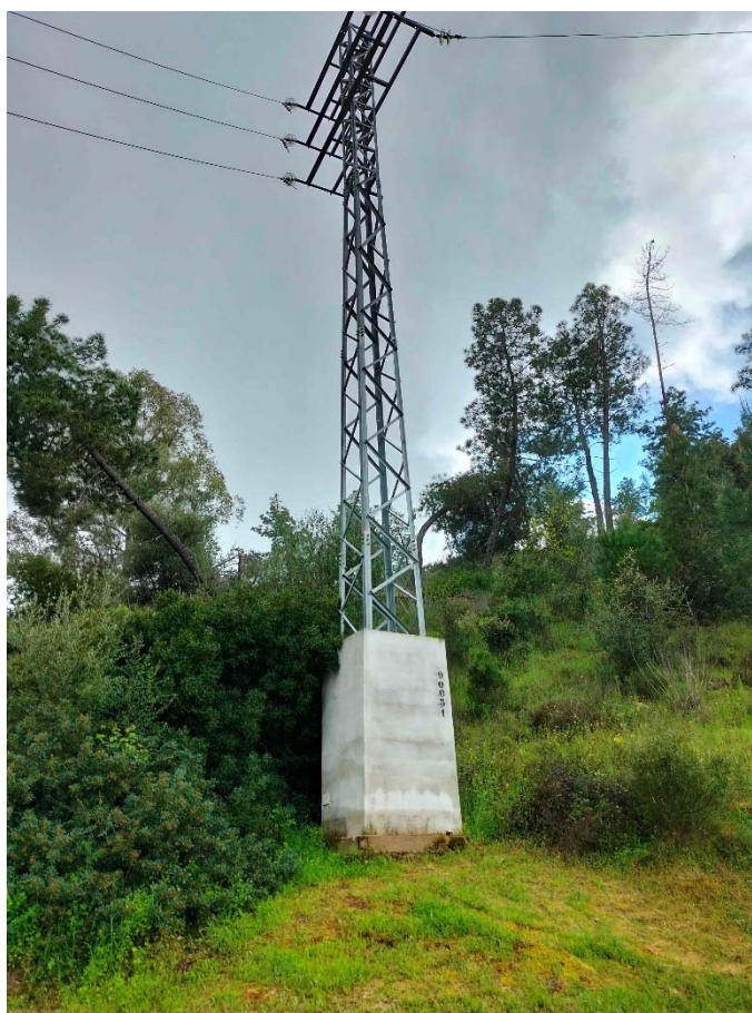
Apoyo 9005-1 en el que se realizará el entronque aéreo-subterráneo
