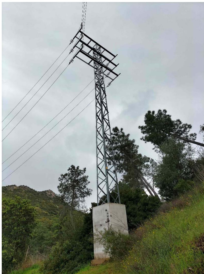
Apoyo 9005-1 en el que se realizará el entronque aéreo-subterráneo
