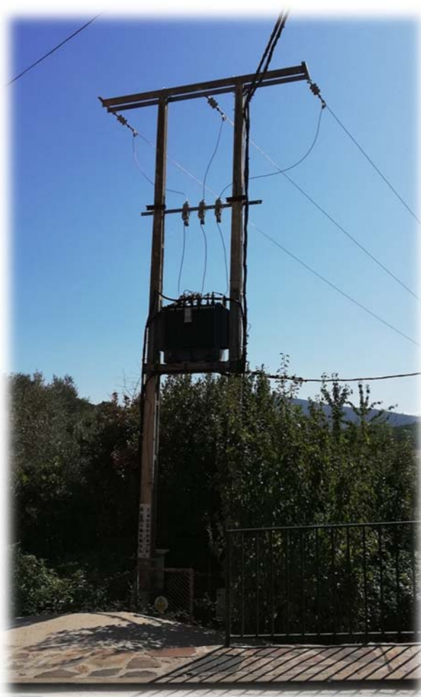
CTIA “Nuñomoral” a sustituir y desmontar
