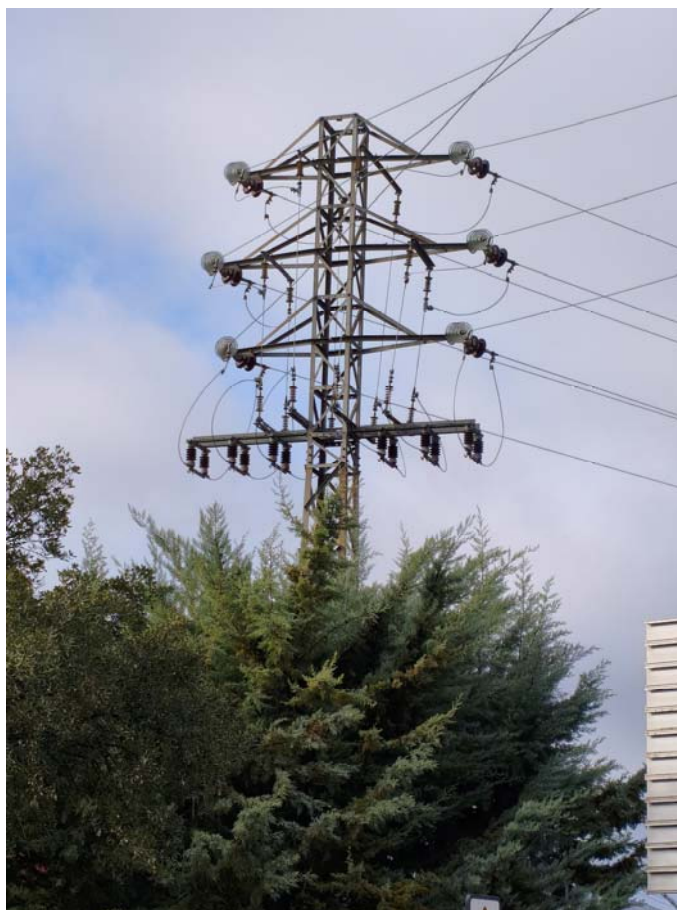
Apoyo 5000-D/C existente de L-4867-03-“La Campiña” y L-4867-04-“Valencia de Alcant.”
