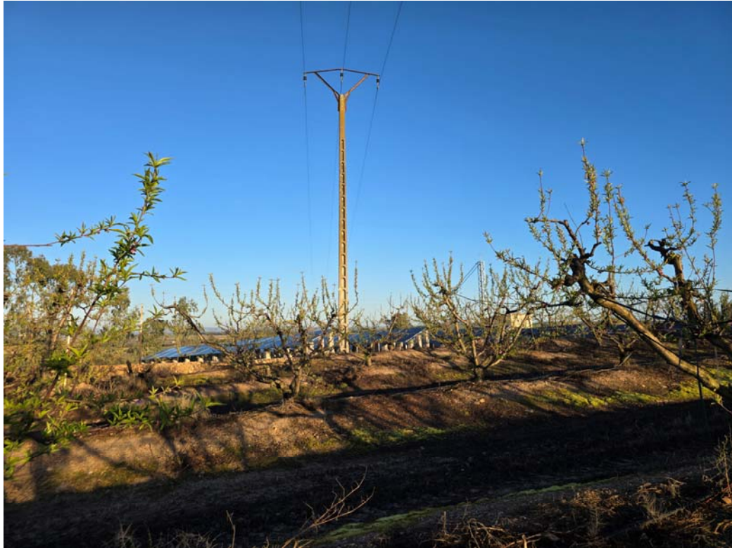
Apoyo 2104 de la LAMT "Torvical" a sustituir y desmontar
