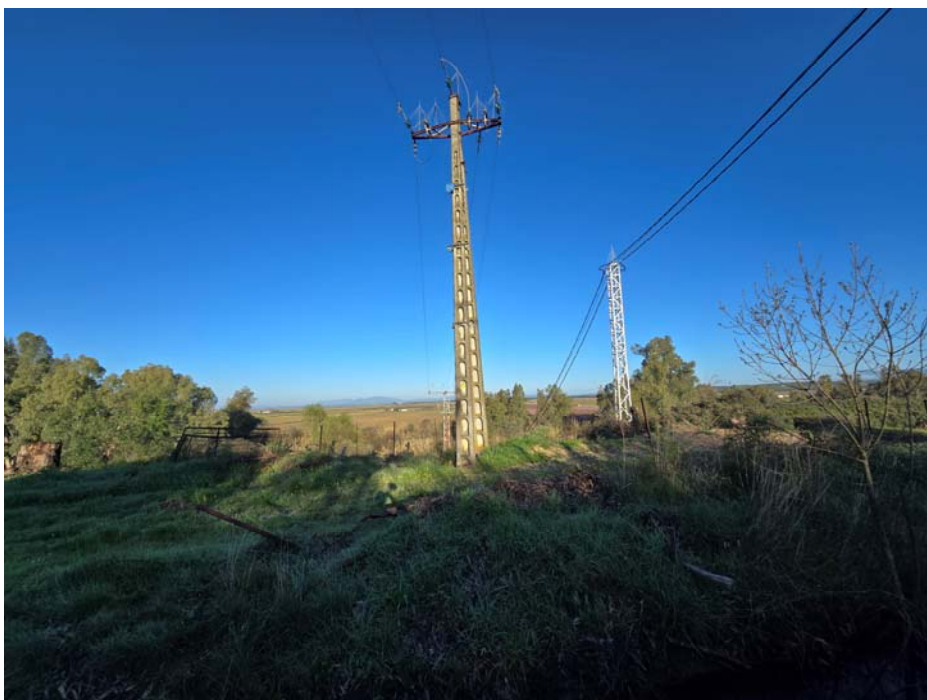
Apoyo 2105 de la L-“Torviscal” a sustituir y desmontar
