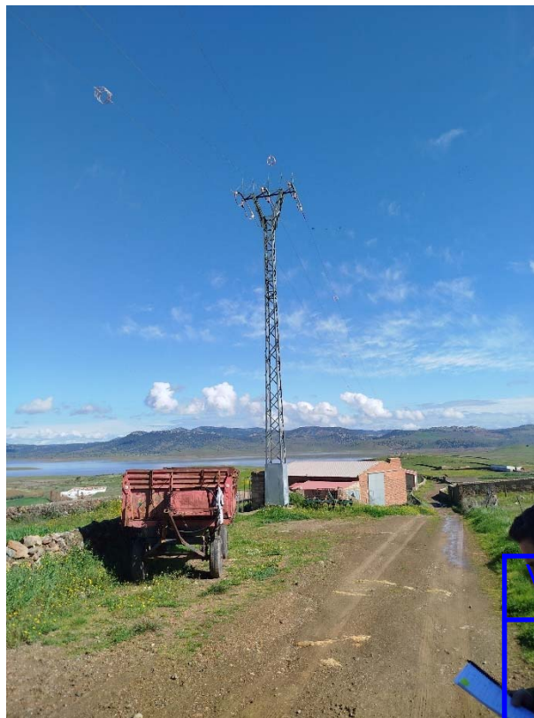
Apoyo 2418 y 2420 de la L-“Cabeza del Buey” donde se realizarán sendos entronques A/S
