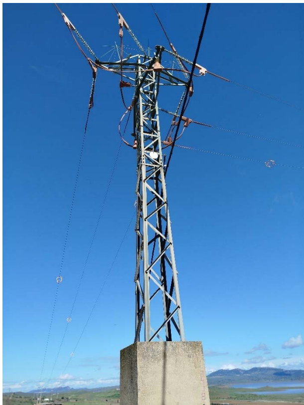
Apoyo 2418 y 2420 de la L-“Cabeza del Buey” donde se realizarán sendos entronques A/S
