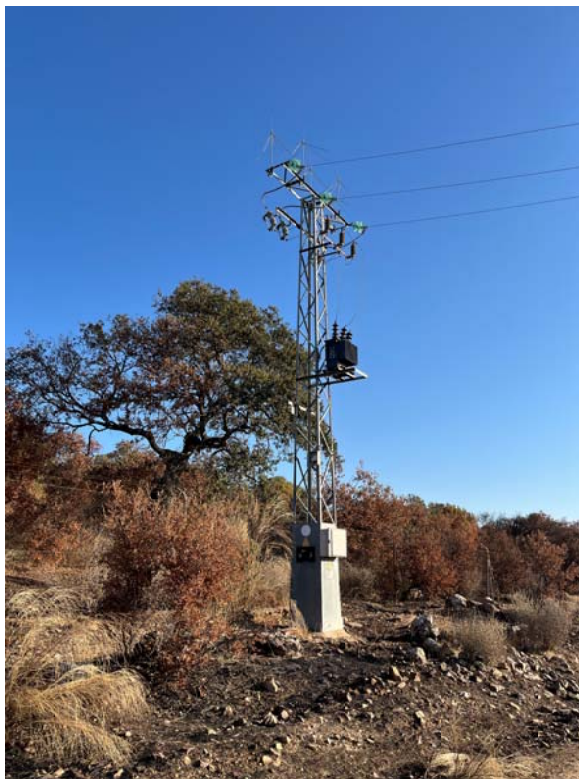
Apoyo 1005 existente a desmontar y derivación a CT particular
