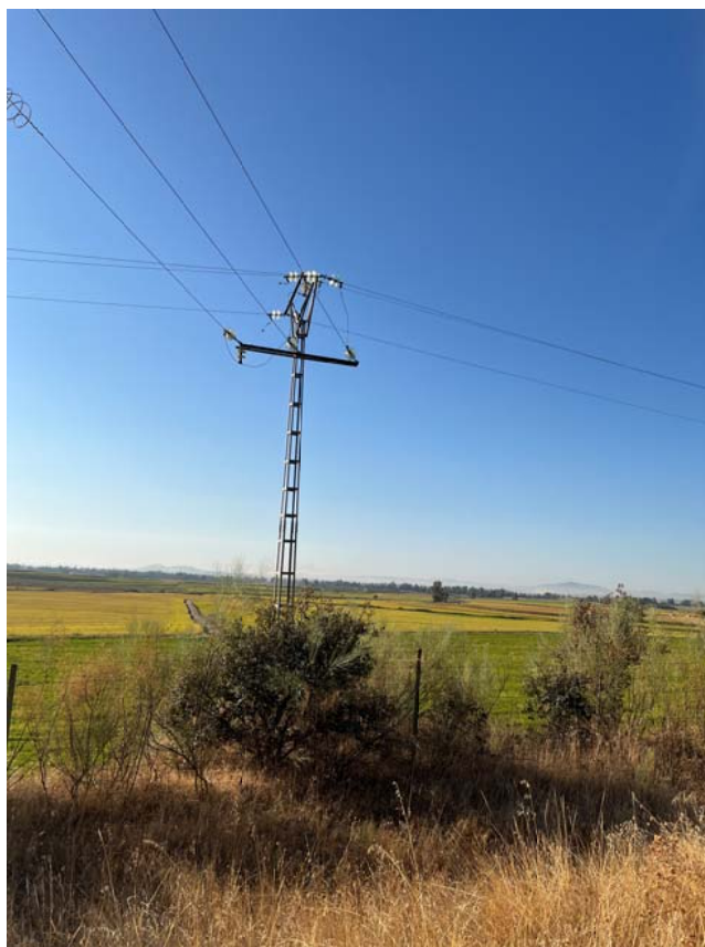
Apoyo 1006 a desmontar
