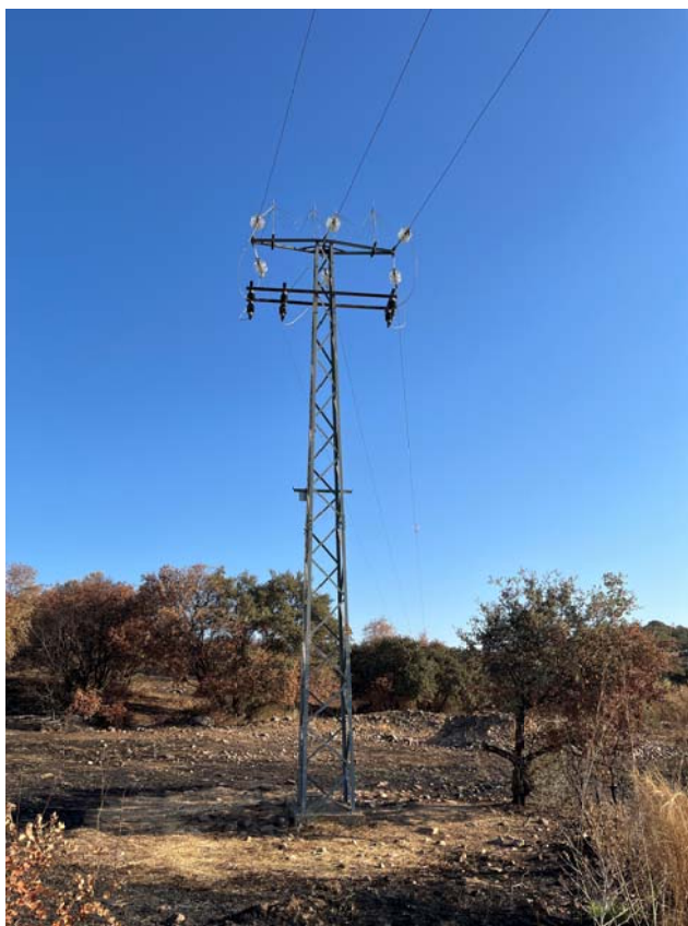
Apoyo 502 existente a sustituir y desmontar
