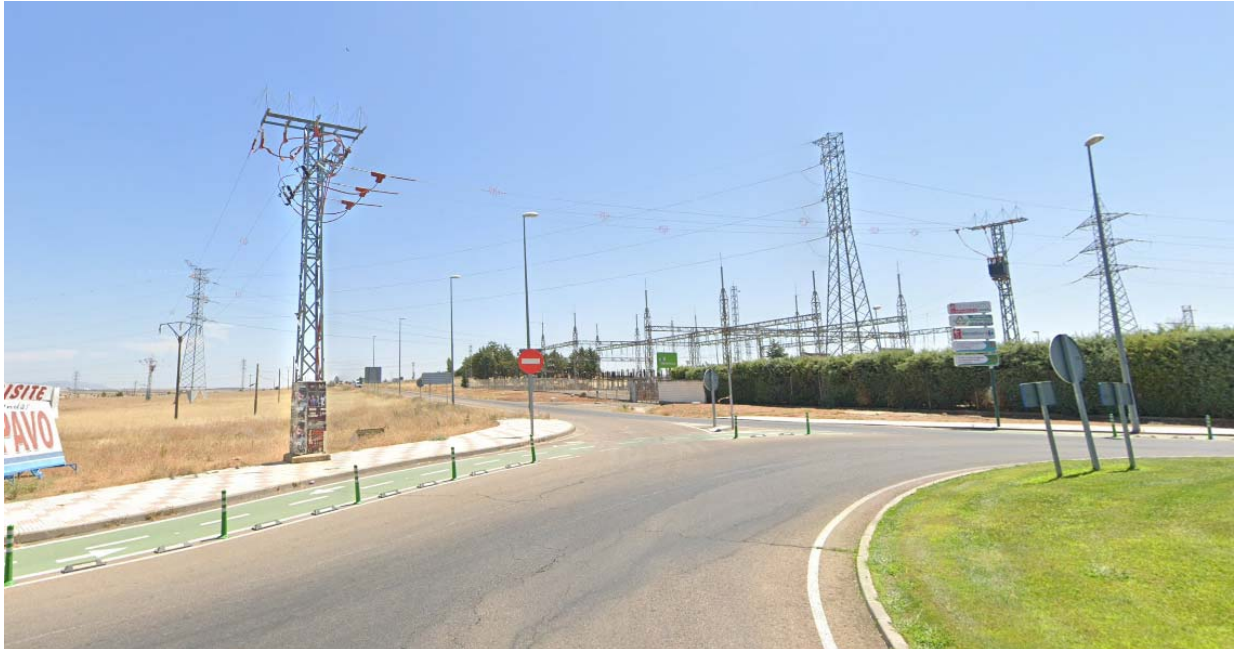
Apoyo 5039 existente y vano de LAMT a desmontar
