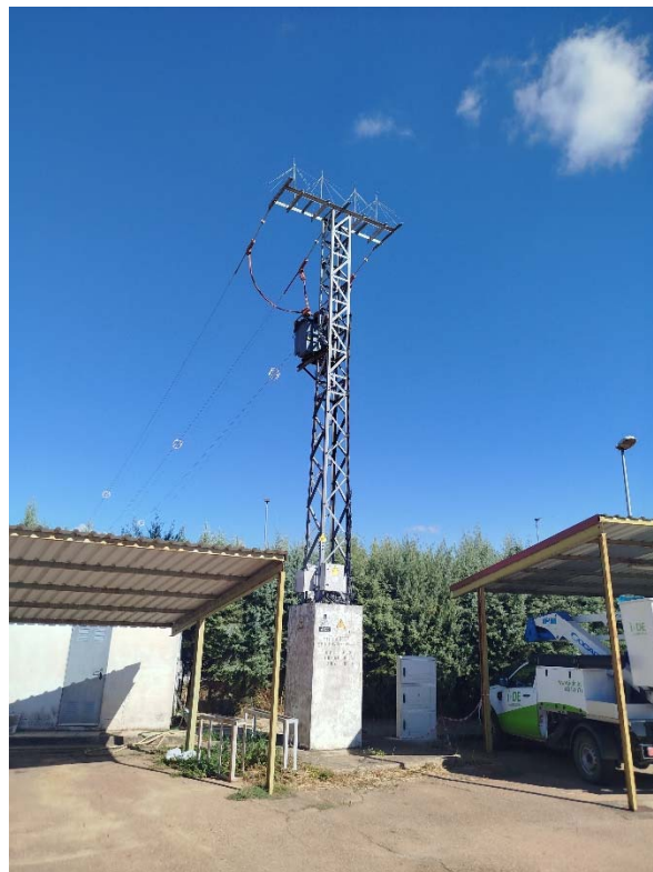
CTIA "Oficinas Iberdrola" a sustituir y desmontar
