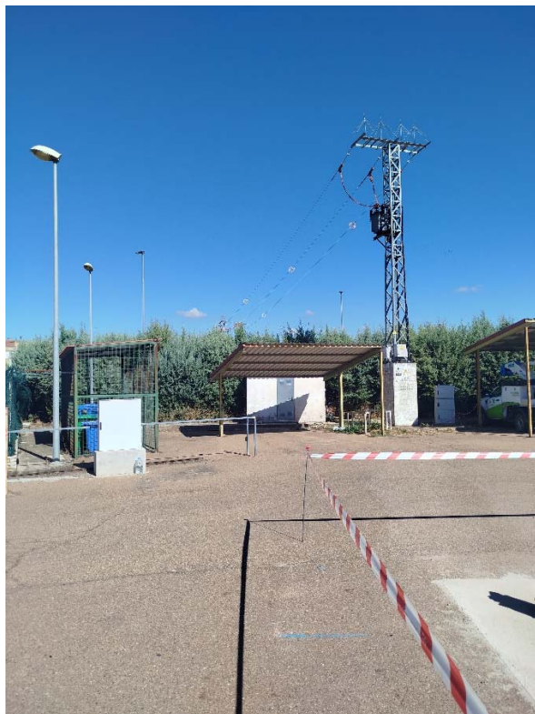
CTIA "Oficinas Iberdrola" a sustituir y desmontar
