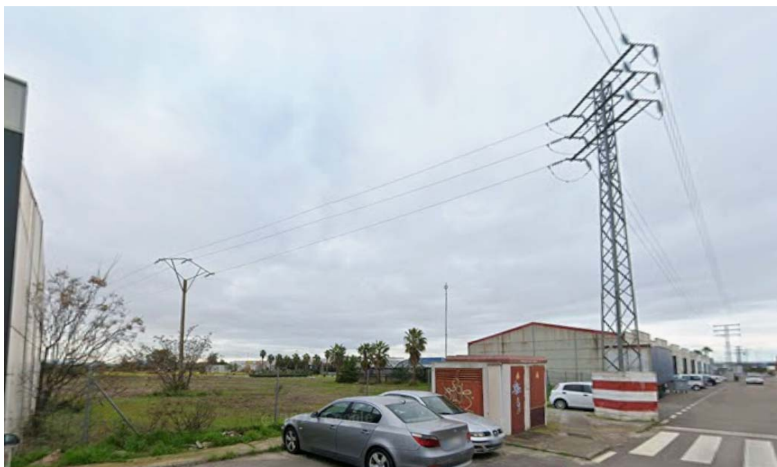
Apoyo 9283 a mantener donde se realizarán 2 entronques aéreo-subterráneos haciendo subida y bajada la nueva LSAT-L22 "Guadiana 1"
