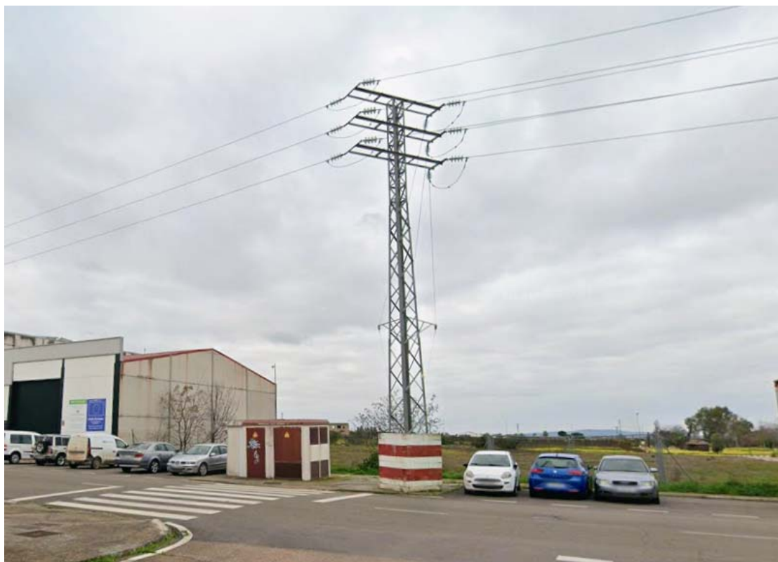
Apoyo 9283 a mantener donde se realizarán 2 entronques aéreo-subterráneos haciendo subida y bajada la nueva LSAT-L22 "Guadiana 1"
