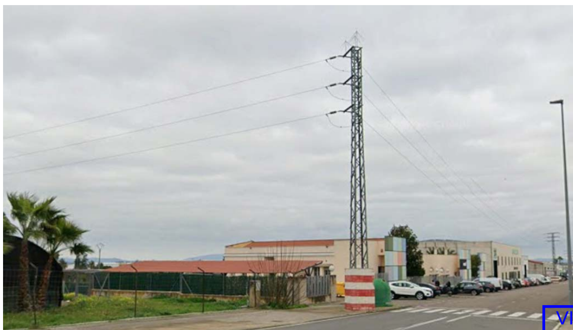
Apoyo 5050 a mantener donde se realizará un entronque aéreo-subterráneo en donde finaliza el soterramiento de la L26 “Medellín” proyectado
