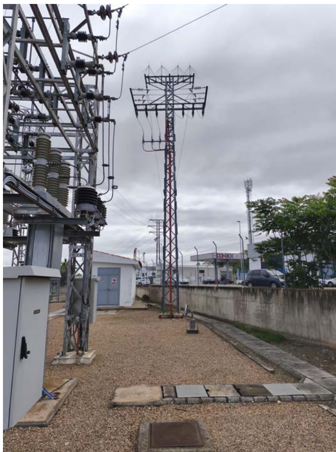
Apoyo existente 5000 de la línea 4870-05-“Felix González” (a pasar a D/C)
