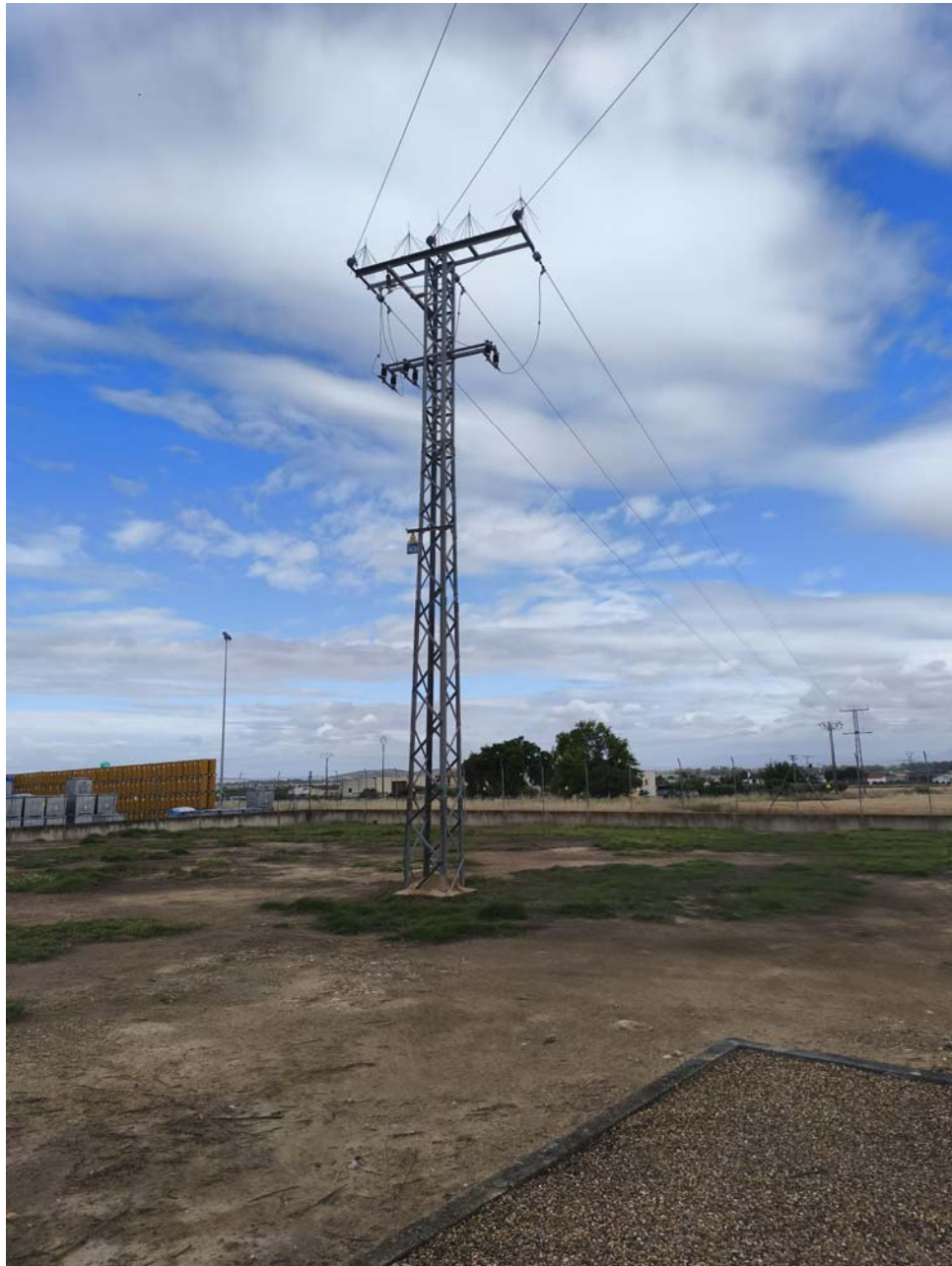
Apoyo existente 5002 de la línea 4870-08-“Riegos” a mantener
