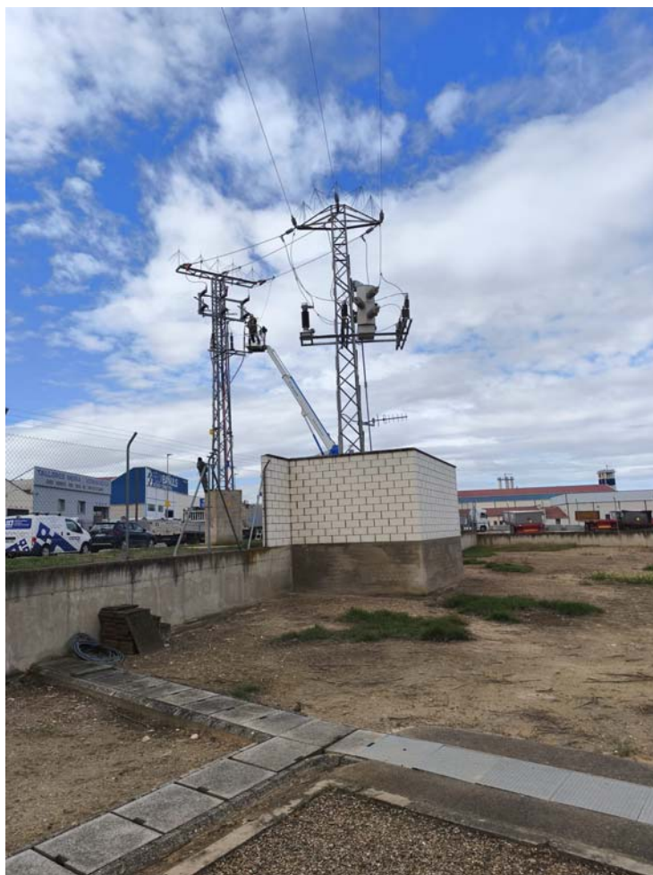
Apoyo 5001 (BA03309) a desmontar y apoyo particular de la L-“ALSAT”
