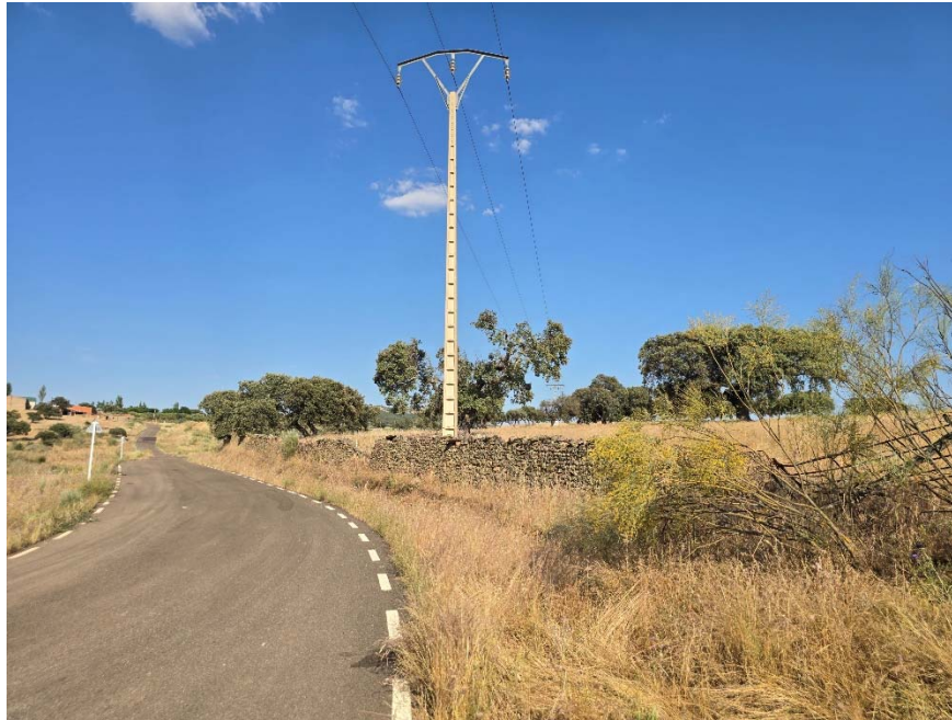
Apoyo 2372 a sustituir y desmontar
