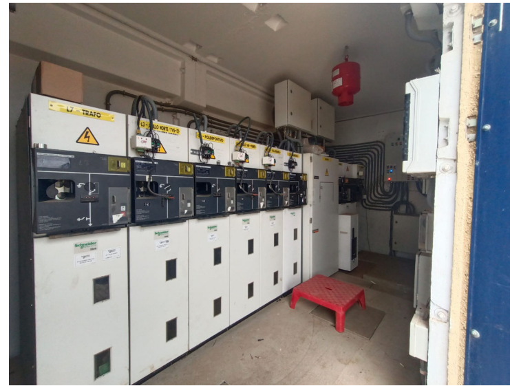
VISTA INTERIOR PUNTO FRONTERA.
